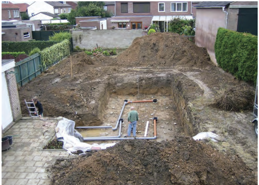
Kunststofleidingen bij vijveraanleg
